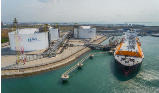
Singapore LNG Corporation, Singapore
