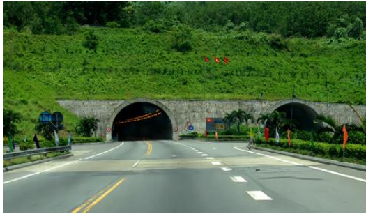
Hải Vân Tunnel, Vietnam
